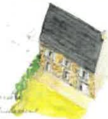
La façade avant est enduite, pour que le pignon, visible sur le côté, soit également rejointoyé
