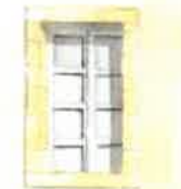
Le linteau d'une fenêtre est en saillie en rapport au reste du mur, cela indique que le reste de mur était destiné à être enduit
